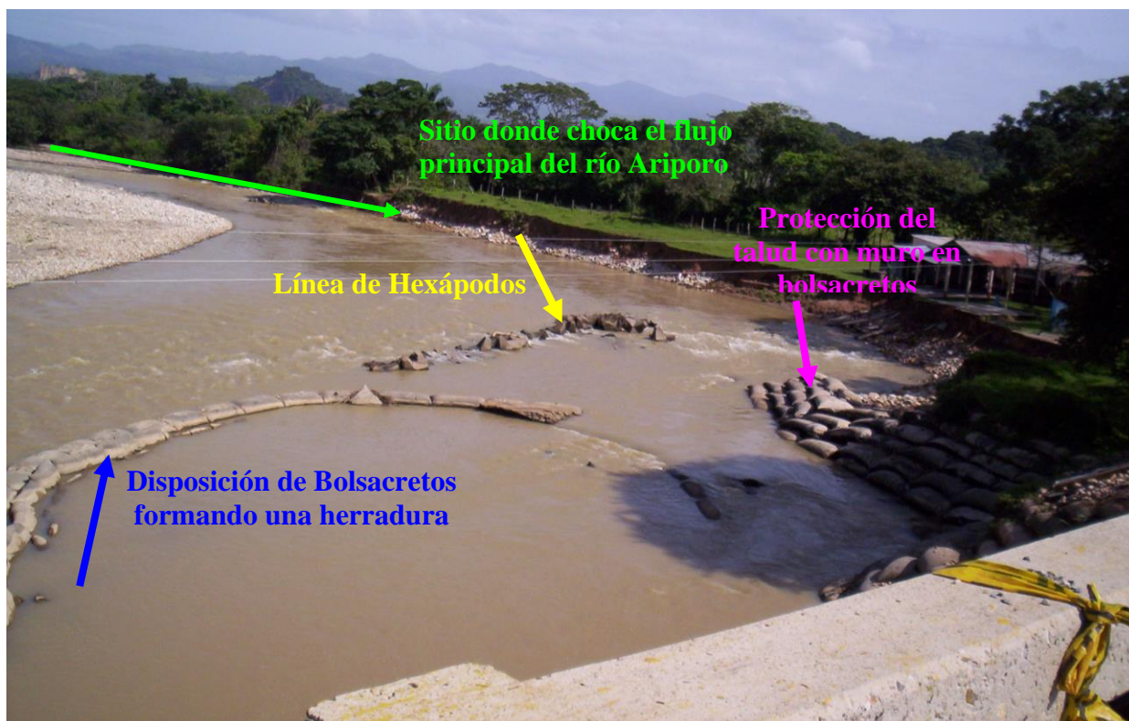
FOTO No. 1: En esta fotografía se aprecian las diferentes obras realizadas por el INVIAS dentro del cauce del río Ariporo, a la altura del puente localizado en la vía Marginal de la Selva, tramo Paz de Ariporo – Tame.
